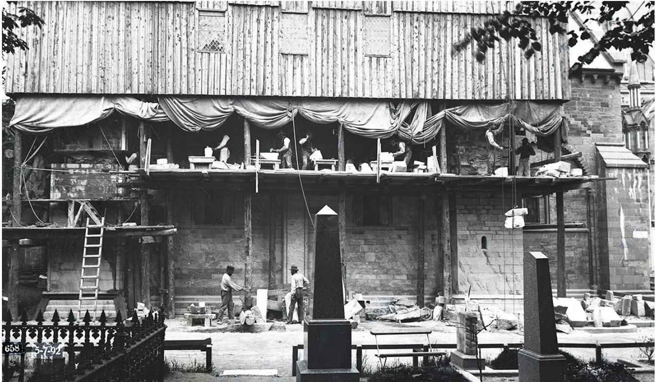
1892: Restaurering av gavlvegg på søndre tverrskip. (Foto 0658)
