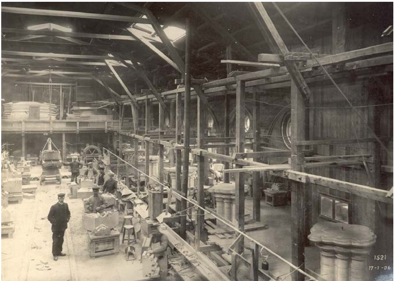
1906: En ung Albertsen i skipet som ble brukt som verksted frem til 1914. Pilarene i søndre midtskipsvegg er fullført, og bueprofiler hugges. (Foto 1521)
