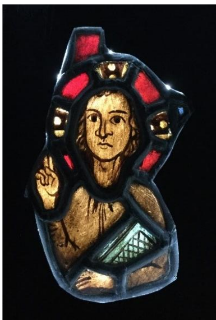
Figur 20, Eksempel på figur omgitt av smale blyprofiler (3,5 mm), der et skifte til bredere bly vil skjule enkelte detaljer langs ytterkanten av glassbitene.
