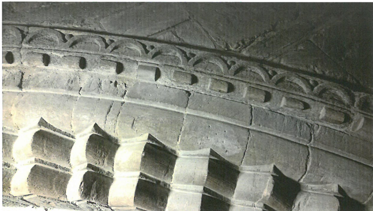
Figur 12: Det ytterste leddet på buen og dekklist. Foto: ES.
