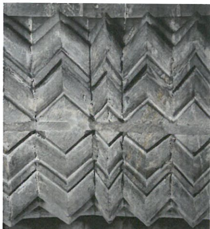
Figur 4: Steinens tykkelse avgjør grad på vinklene. Foto: HG.
