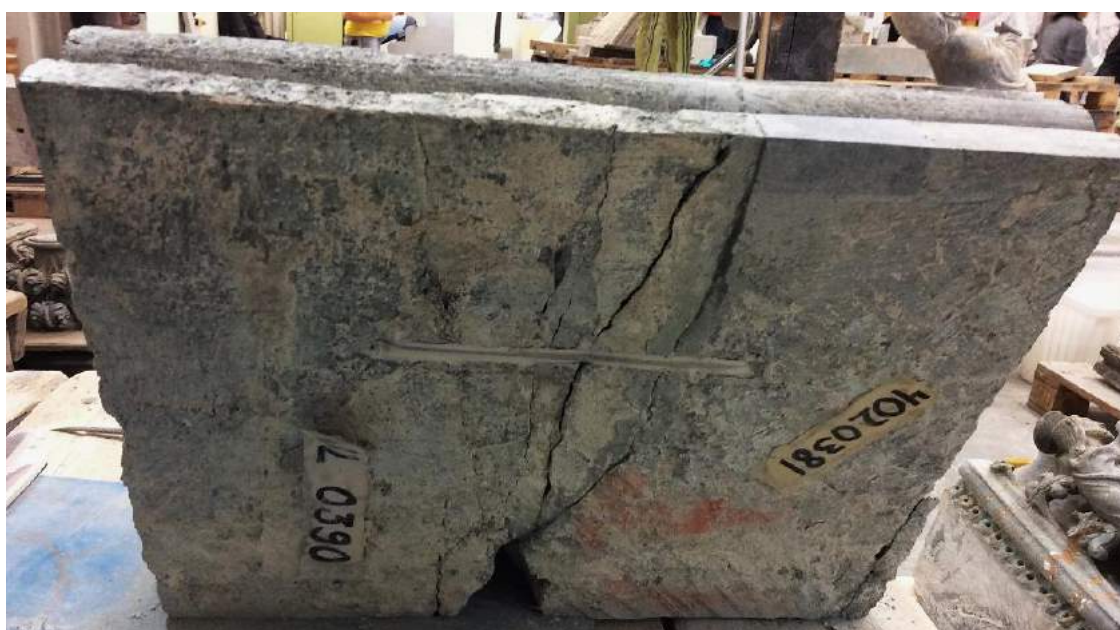
Figur 13. En av krampene påsatt tvers over sprekker på steinens «bakside».
