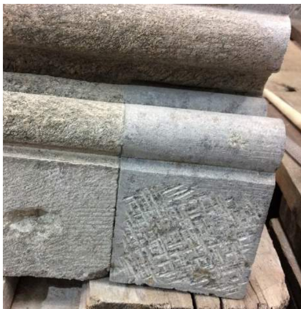
Figur 7. DSU4020150. Til venstre: innfelt ny bit, til høyre: modellering på profil (lysere farge enn steinen).
