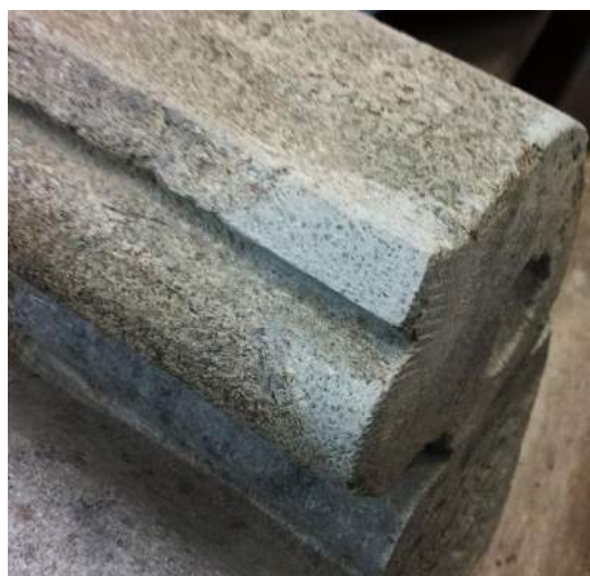
Figur 7. DSU4020150. Til venstre: innfelt ny bit, til høyre: modellering på profil (lysere farge enn steinen).
