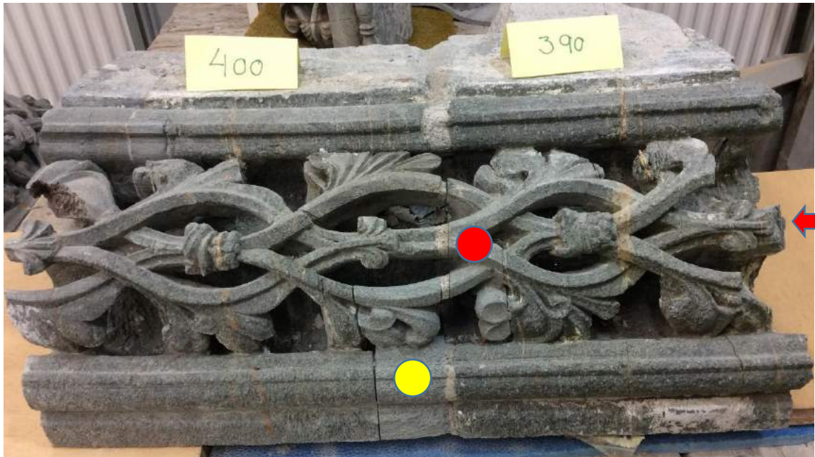
Figur 10. DSU4020390 før adskillelse fra – 0400. Tidligere utførte innfelling markert med gult og rødt (den markert med rødt løsnet). Rød pil markerer området hvor brudd i materialet oppstod ved demontering.
