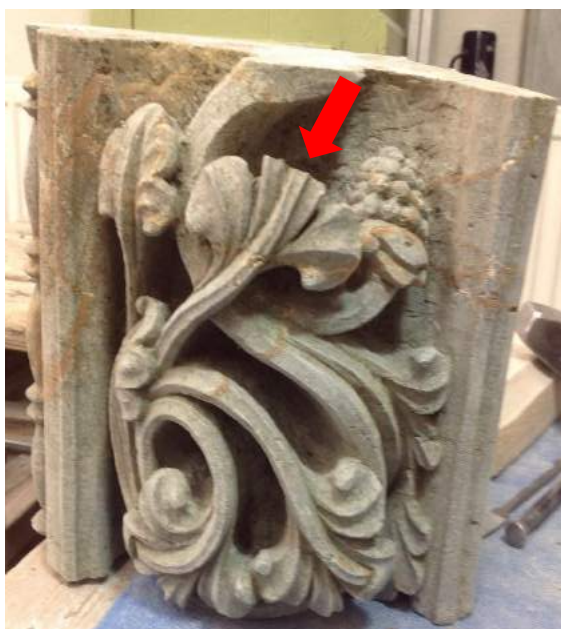
Figur 14. DSU4020550. Rød pil markerer hvor pålimt del hadde løsnet. Til høyre er biten limt på igjen.
