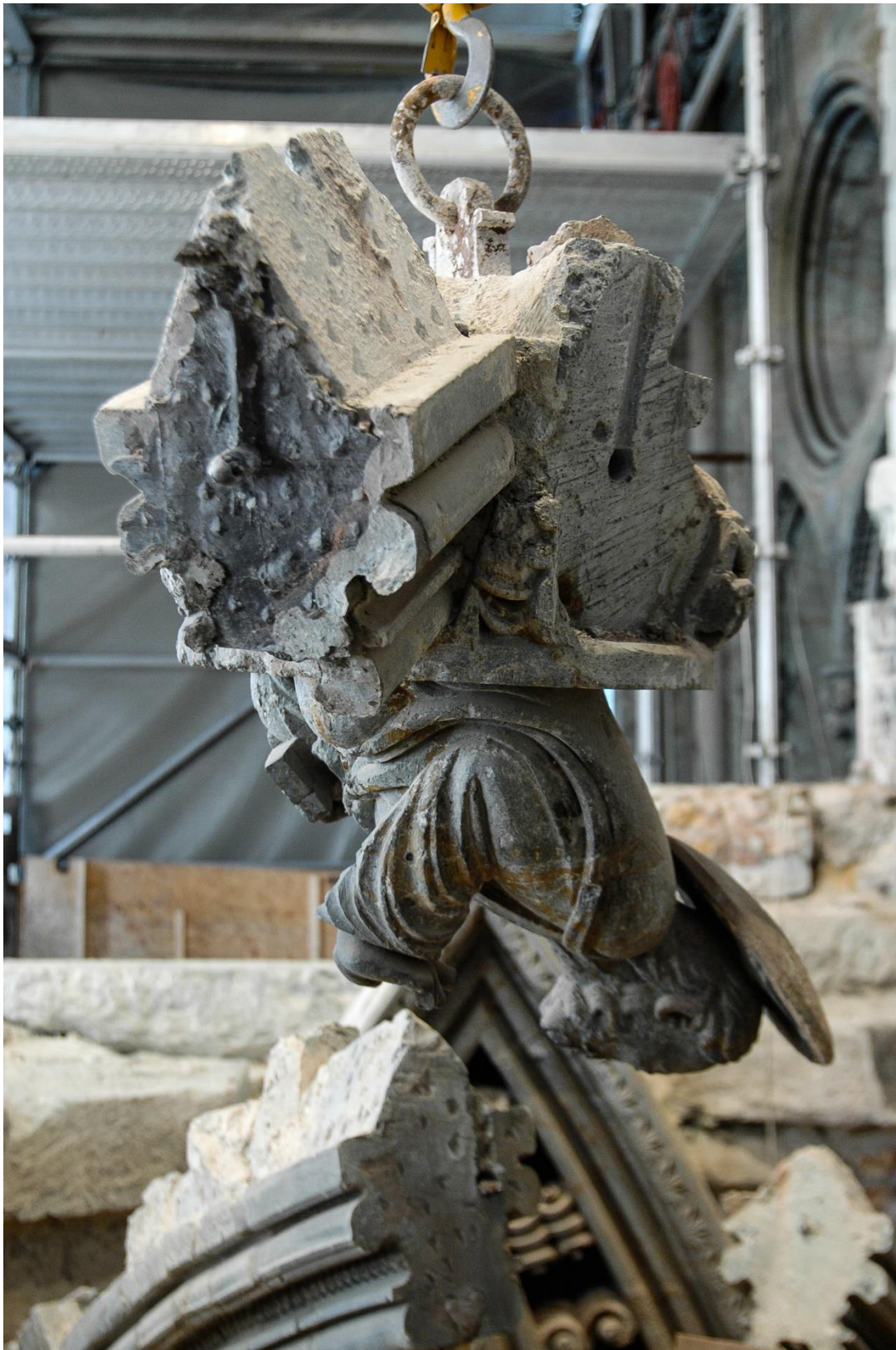
Demontering av hvelvet, med utheising av sluttsteinen.
