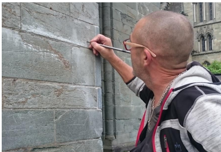
Figur 12. Fjerning av "skrammer" på vegg.
