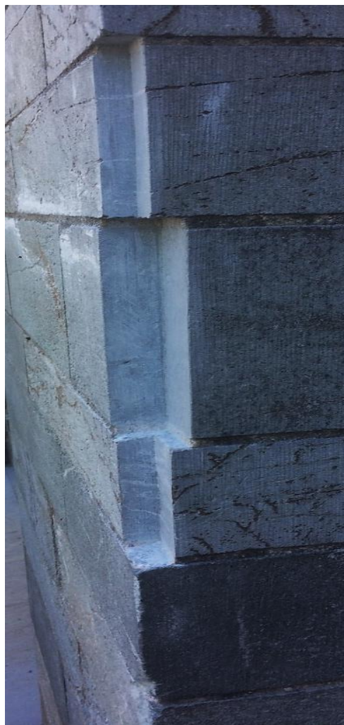
Figur 2. Til venstre: Tilhugging av "tomter" på det skadde hjørnet, til høyre er «tomtene» ferdig hugget.
