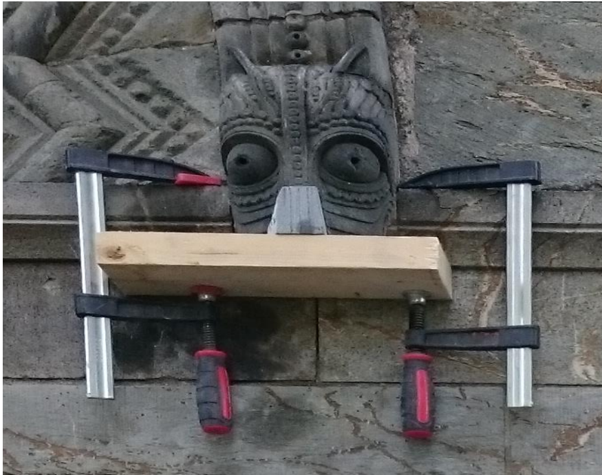
Figur 6. Innfelling limt og sikret mot forskyvning.
