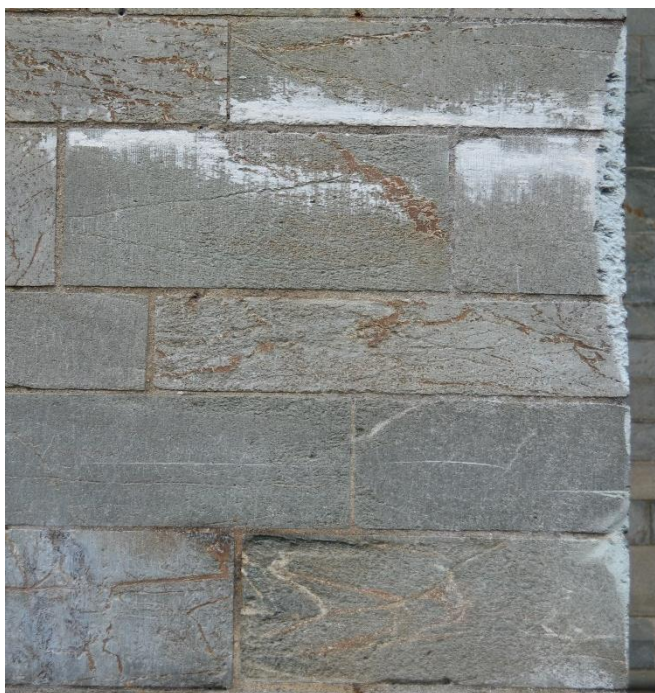
Figur 1. Skadet nese, veggliv og hjørne. (Foto til høyre: Ronald Hübner, bildet er beskåret).
