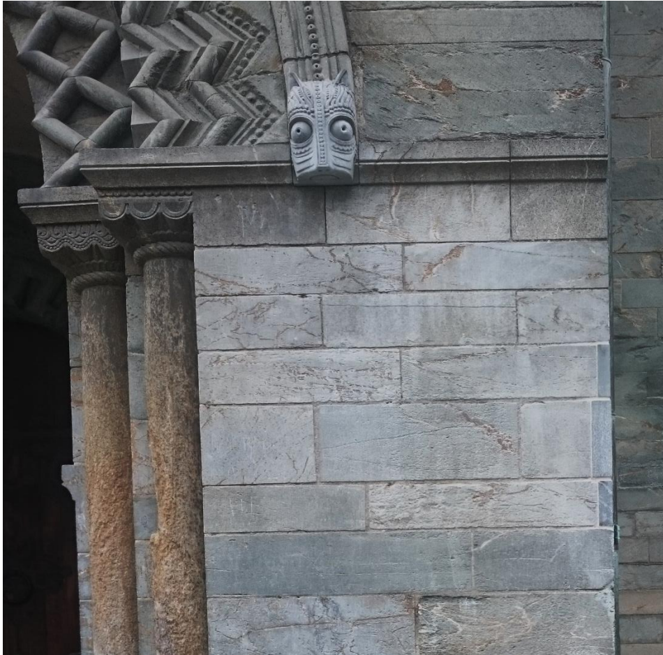
Figur 14. Området etter utbedring av skadene.
