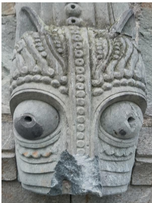
Figur 1. Skadet nese, veggliv og hjørne. (Foto til høyre: Ronald Hübner, bildet er beskåret).
