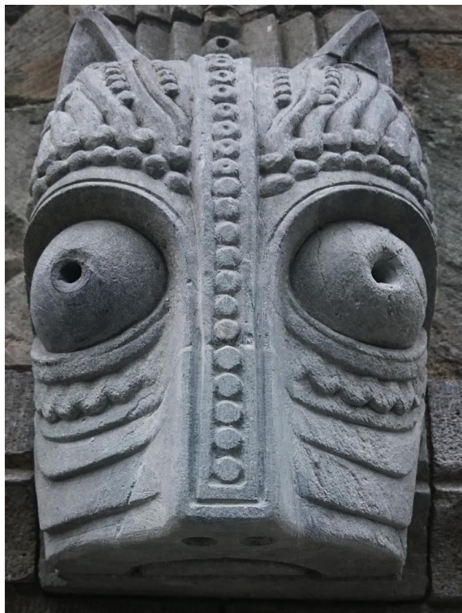
Figur 9. Innfelling ferdig tilformet (fotografert etter rengjøring av hele hodet).
