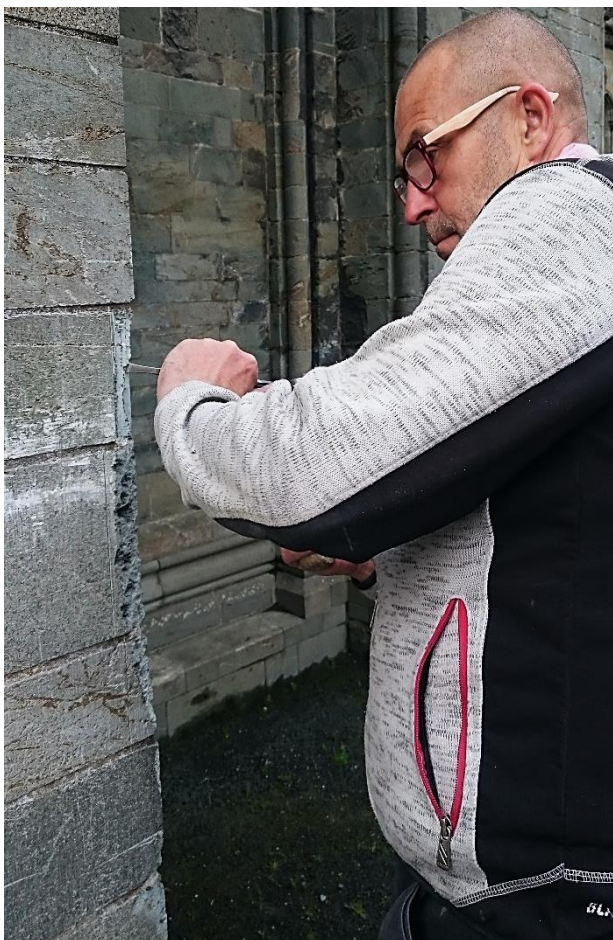
Figur 2. Til venstre: Tilhugging av "tomter" på det skadde hjørnet, til høyre er «tomtene» ferdig hugget.
