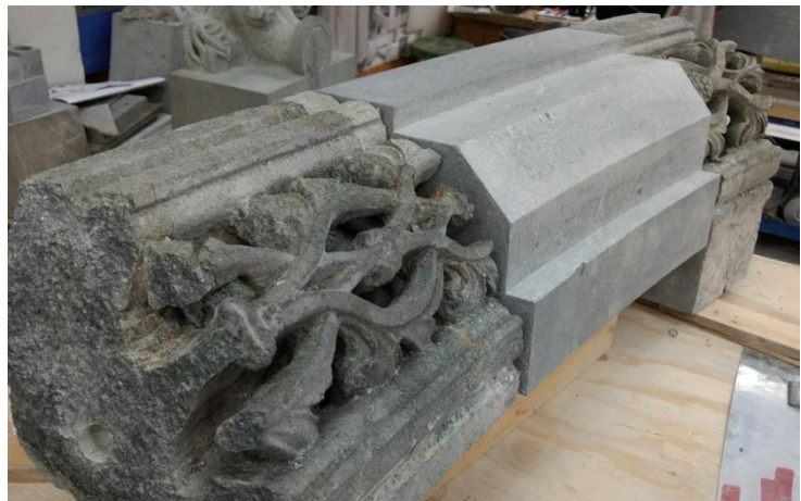
Dobbeltsjekking av profilanslutning med originalsteinene
