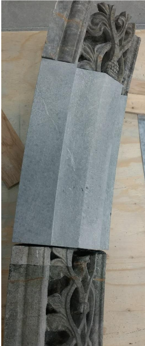
Dobbeltsjekking av profilanslutning med originalsteinene
