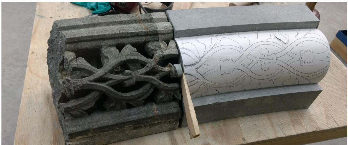
Det avtegnede originalornamentet blir limt på den buede kvartstaven og justert litt i forhold til nabosteinens ornament.
