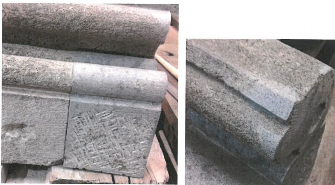
Figur 7. DSU4020150. Til venstre: innfelt ny bit, til høyre: modellering på profil (lysere farge enn steinen).
