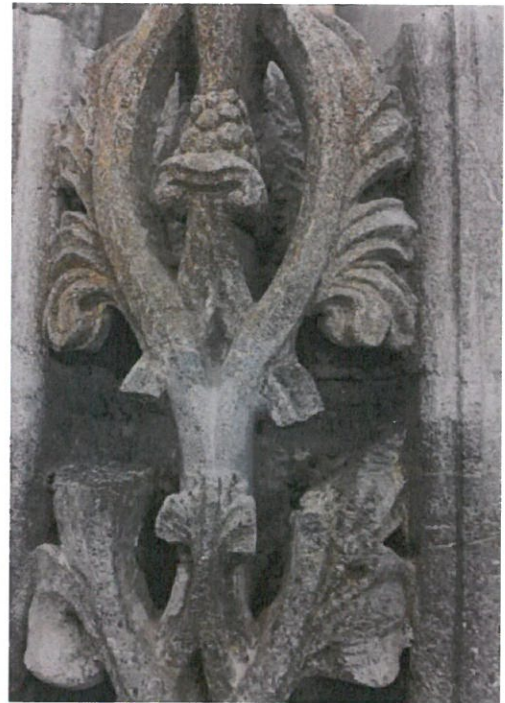
Figur 12. DSU4020390 limt sammen med -0381 (steinene står opp-ned på bildene). Til høyre: Modellering i sammenføyningen mht. styrke. Øvrige mangler betraktes som kosmetiske avvik med liten betydning for helhetsinntrykket.
