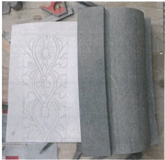
Figur 8. Emne til ny stein, DSU4020210, er tilformet og ornamentikken tegnet.
