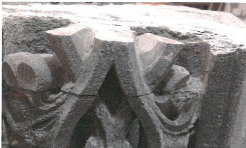
Figur 11. Innfelling limt på igjen (del markert med rødt på fig. 6).
