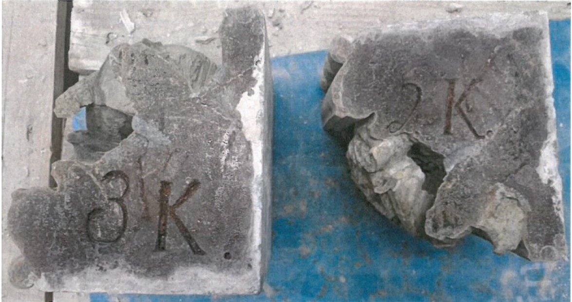
Figur 4. Nummerering på steiner i midtre ornamentbue. Fargen på flatene er rester av lim.
