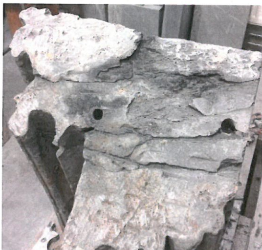
Figur 18. Eksempel på utført sammenliming. Deler i spissen av buen limt på, til venstre sett ovenfra, til høyre fra siden.
