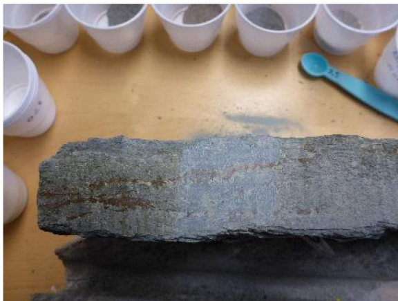
8 Skade på stein, manglende hjørner og kanter (foto: NDR)
