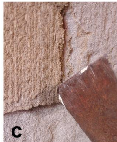
21 Bildet viser fjerning av akrylbasert mørtel ved hjelp av etanol (Foto: Thibault Demoulin)
