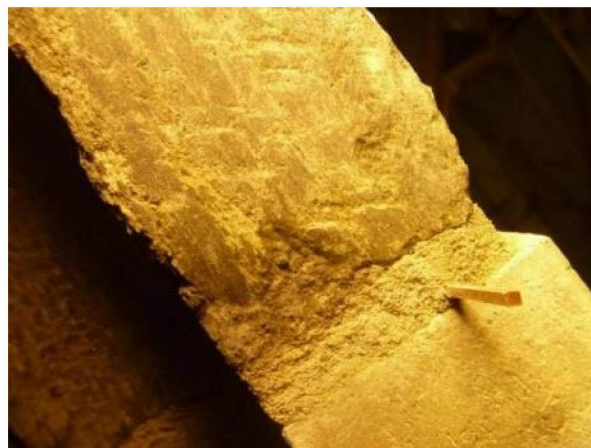
17 Bildet viser beskyttelseslag på murt fuge (foto: Rebecca Reid)
